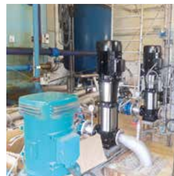
Remplacement, entre autres, de 2 pompes et mise en place d'une 3 e
